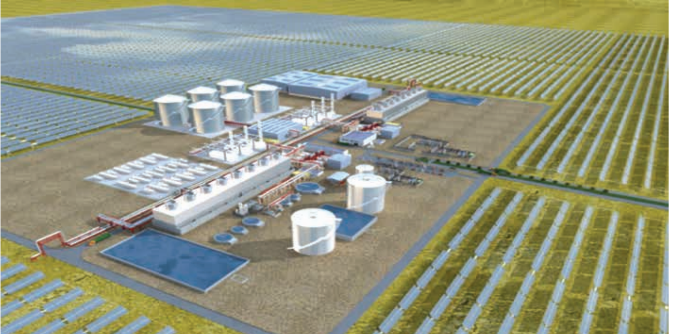
Güneş Termal Güç Santrali (Arizona, ABD)
